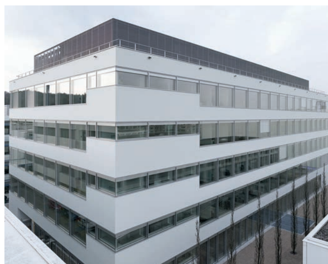
Bild 5. Laborgebäude für Qualitätskontrolle und -sicherung der F. Hoffmann-La Roche AG
